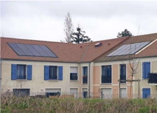
panneaux intégrés à la toiture pour une bonne insertion paysagère
