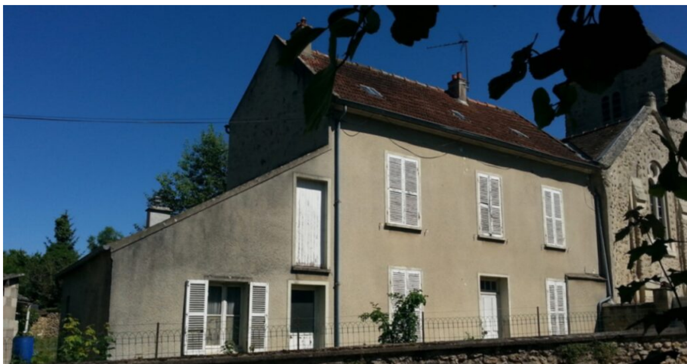
Le Presbytère avant travaux
